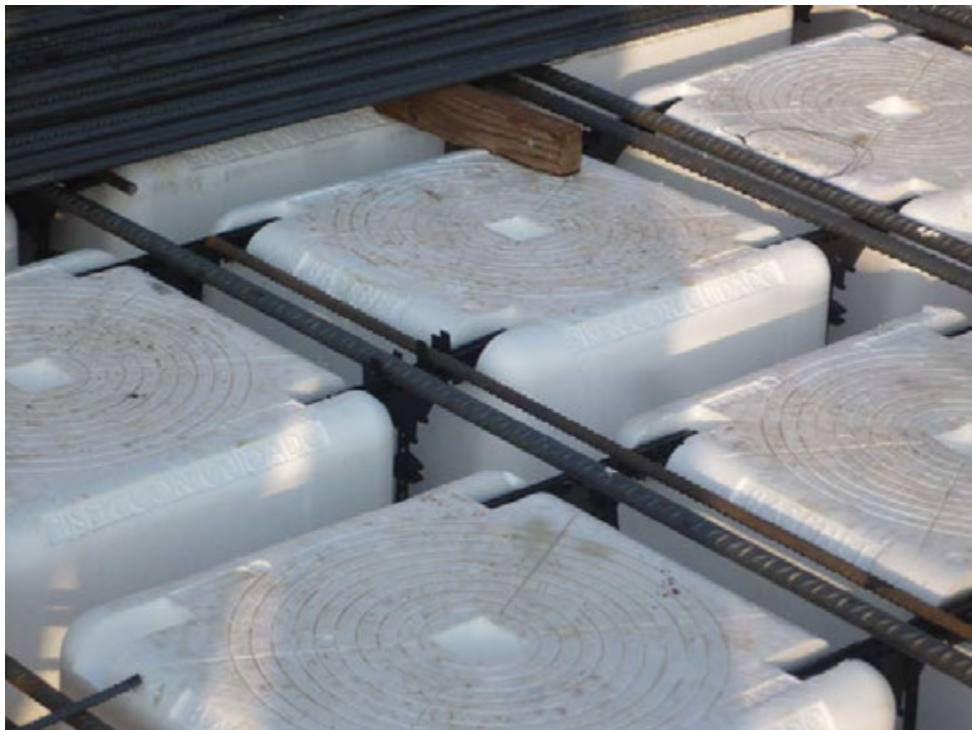
Montaje de Armadura Superior.
