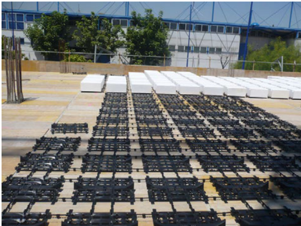
Montaje de Bloques Aligerantes.
