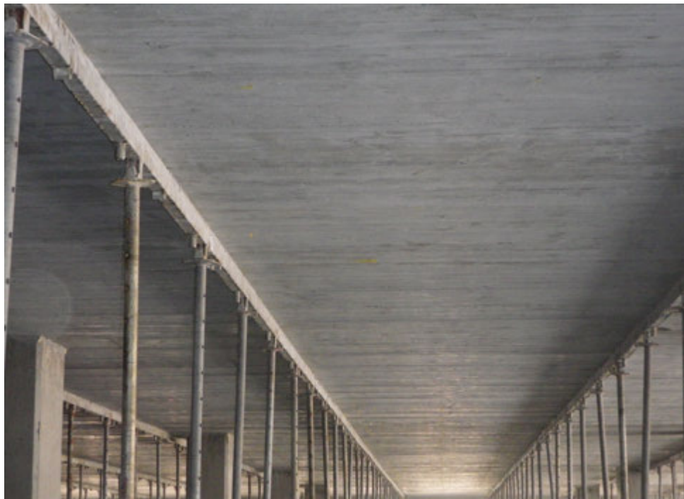
Acabado Inferior Forjado.
