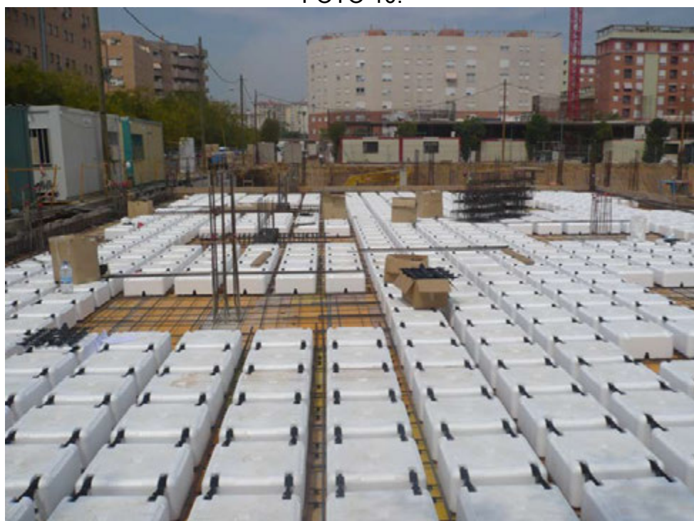
Montaje de Bloques Aligerantes.
