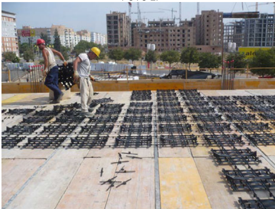
Replanteo del Sistema. Montaje de Plantillas y Replanteados.
