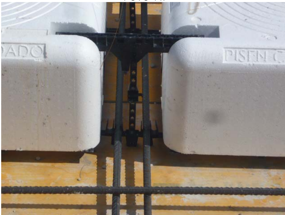
Montaje de Armadura Superior.
