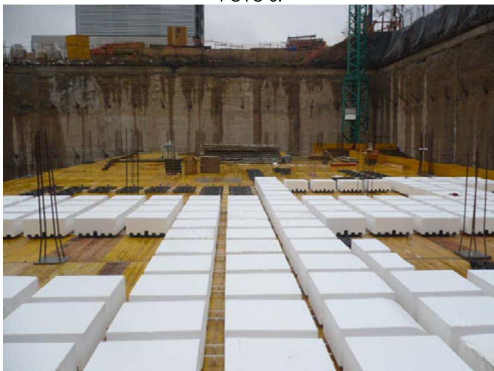
Montaje de Bloques Aligerantes.
