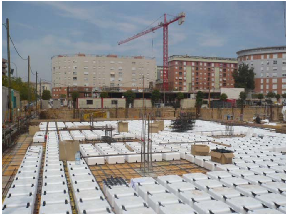
Montaje de Bloques Aligerantes.
