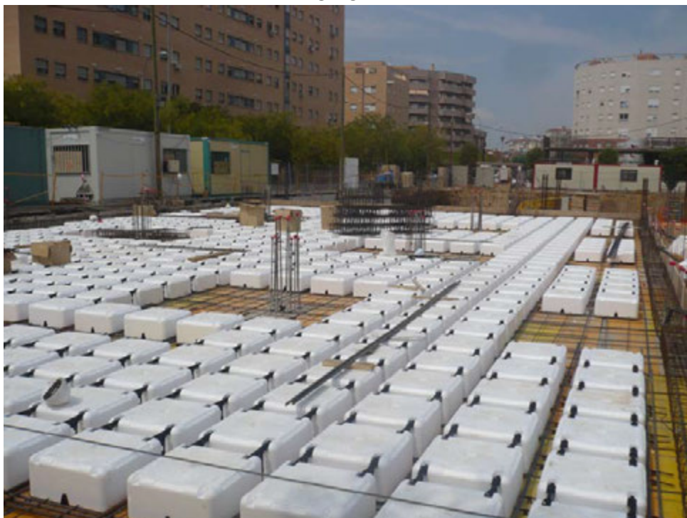
Montaje de Bloques Aligerantes.
