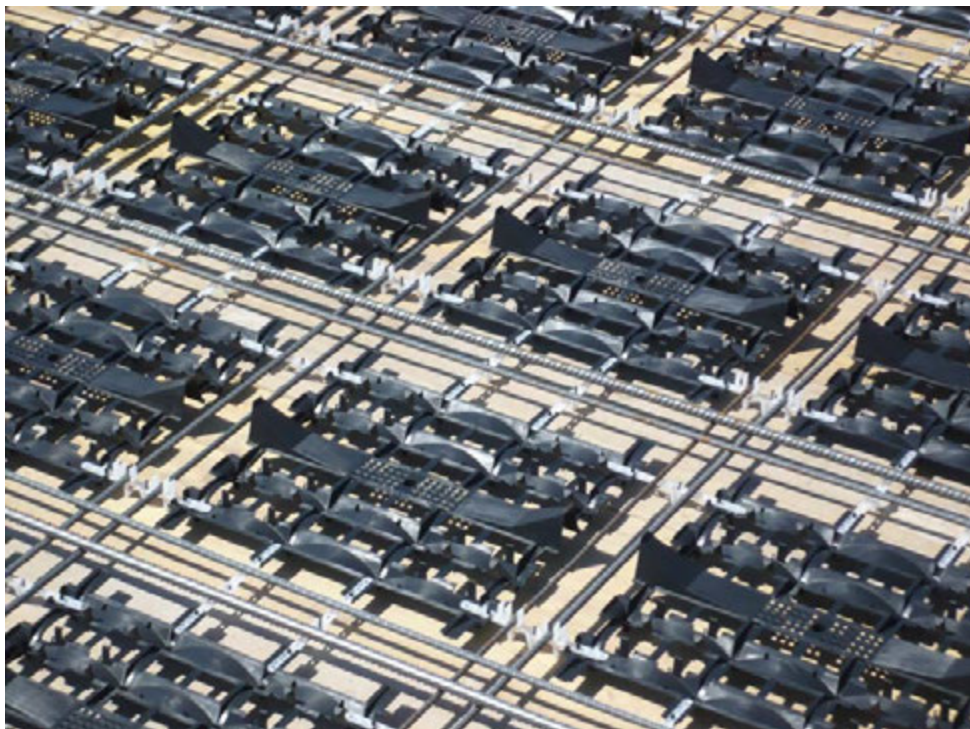
Montaje Armadura Inferior.
