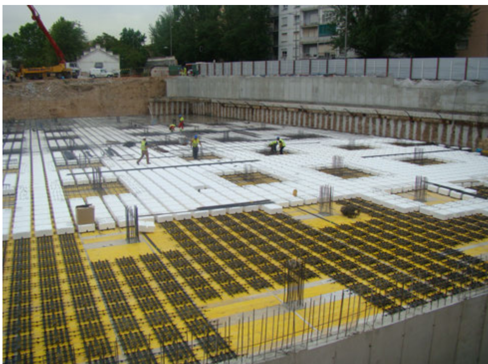
Montaje de Bloques Aligerantes.
