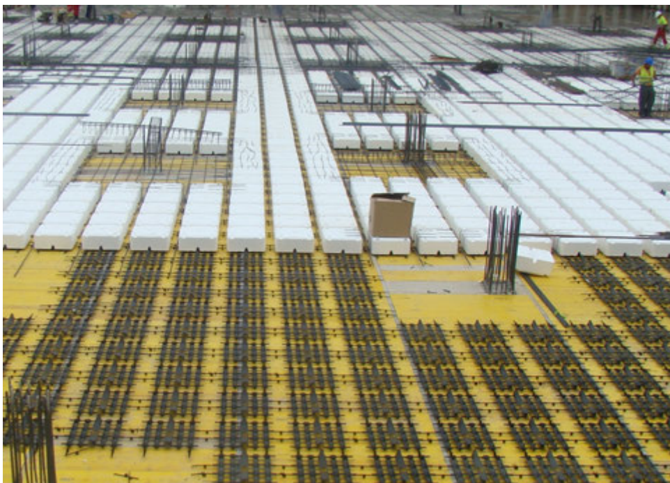
Montaje de Bloques Aligerantes.
