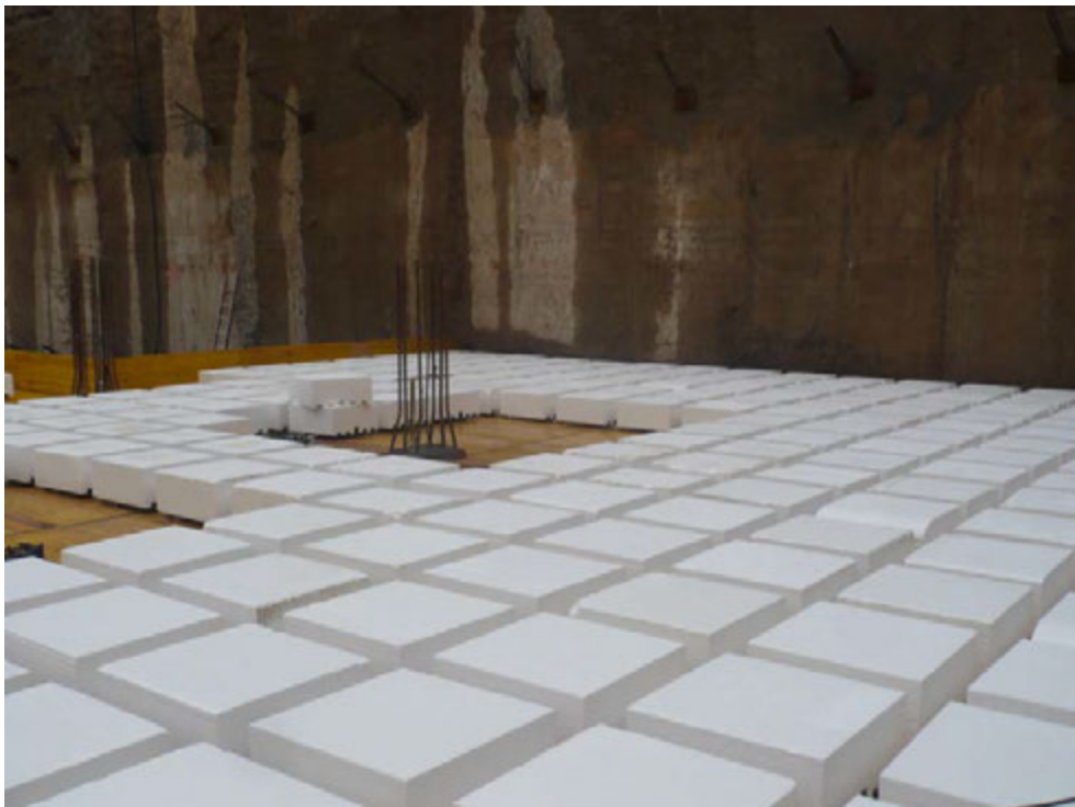
Montaje de Bloques Aligerantes.
