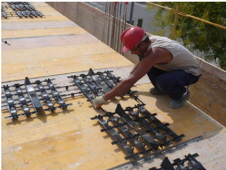
Replanteo del Sistema. Montaje de Plantillas y Replanteados.
